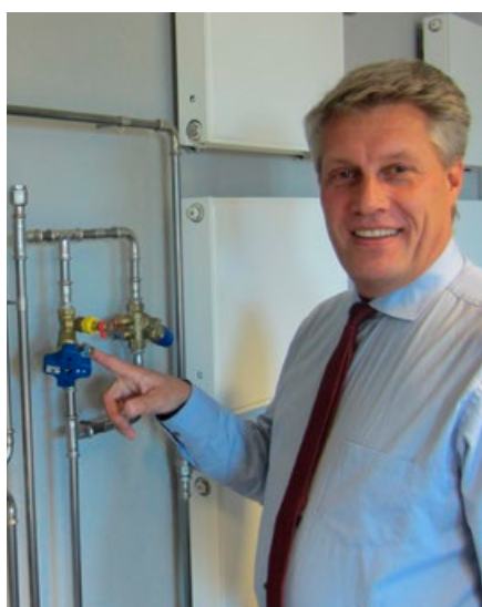
Kent Nilsson, projektledare för LFB, demonstrerar regleringsventil i mässing.
